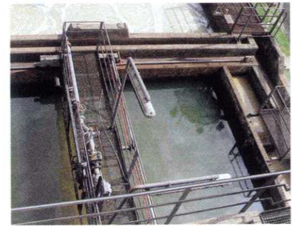
Oben: Schlammabtrieb im Nachklärbecken Unten: 7 Stunden nach TERRANA®-Zugabe
